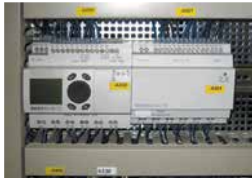
Hình 4: Môđun điều khiển nhỏ đặt trong tủ điện
