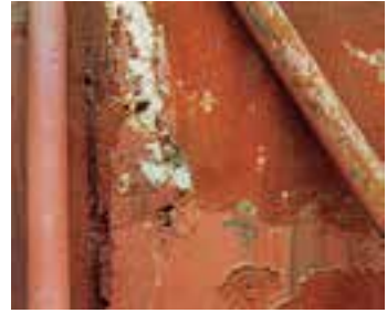
Hình 1: Cấu kiện bị phá hủy vì ăn mòn
