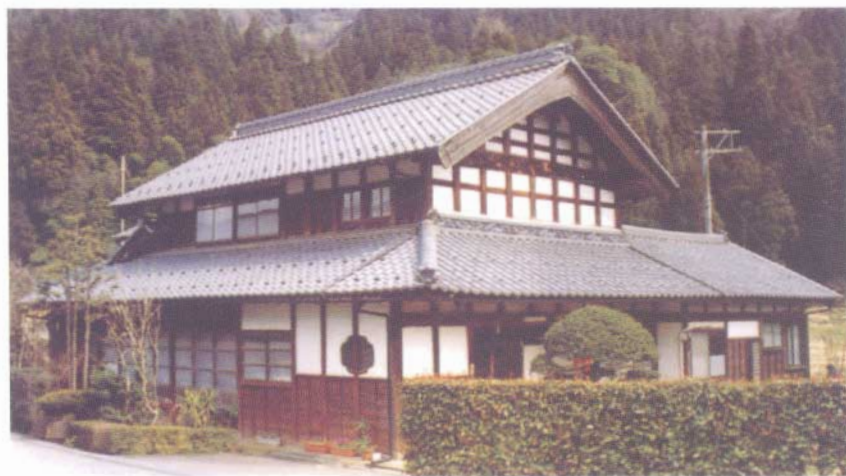
Loại motra 1, một dạng nhà ở nông thôn được xây cất gần đây ở Quận Fukui mang dáng dấp truyền thống và hiện đại. Những khoảng không giữa các cột lợp ra được phủ bằng thanh tre hay gỗ, trong và ngoài bề bộn trộn rơm rỗi quét vôi trắng.
