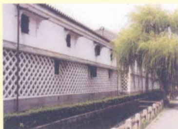
Đáy của nhà kho ở Chùa Higashi Honganji, Tây Kinh được bảo vệ bằng gạch hình thoi. Những chỗ nổi được trát vữa để giữ gạch yên vị.
