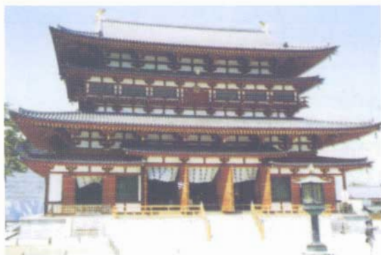
Tái tạo Chính sảnh ngôi đền Yakushiji ở Nara được hoàn tất năm 1976, sau khi đã bị tàn phá hàng thế kỷ trước đó, trên cơ sở chứng cứ khảo cổ, tư liệu Thời Bình An, và một ngôi chùa còn lại trên mặt nền.
