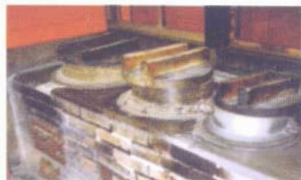
Lò nấu bằng củi làm bằng gạch trong nhà bếp của ngôi nhà Yoshijima.
