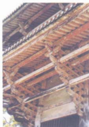
Chi tiết Cổng Nandaimon ở Tōdaiji, trình bày hệ thống ngànm nhiều tầng.
