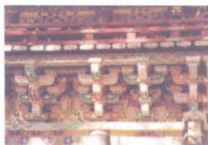
Chi tiết của tháp treo chuông, cho thấy hệ thống ngàm công phu và những trang trí sắc sảo.
