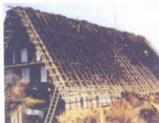
Mái đã lấy rơm cũ đi để chuẩn bị lợp rơm mới.
